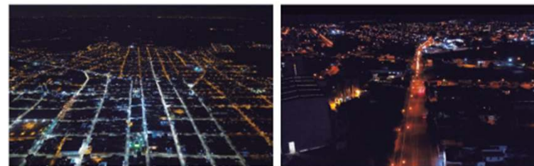
São mais de 60 km de ruas com iluminação eficiente. O objetivo é contemplar toda a área urbana com iluminação pública eficiente
